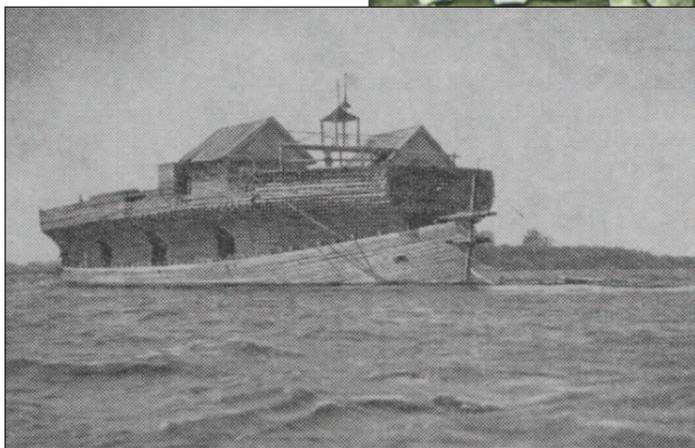
Беляна на Ветлуге. Так сплавлялась продукция лесопильного завода. Нач. XX в.
